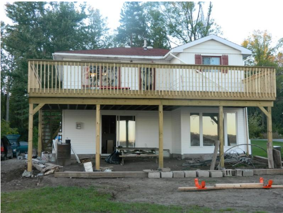
水源禅師の建設中のクティ
